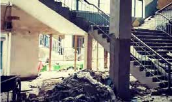
暴露的混凝土柱
