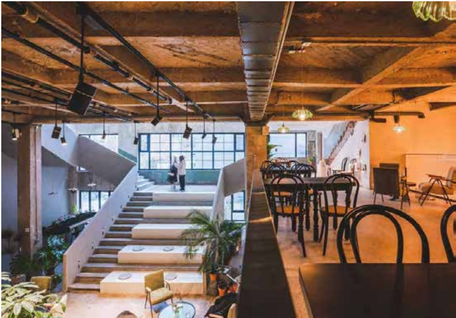
3. 裸露的现浇混凝土结构天花板
