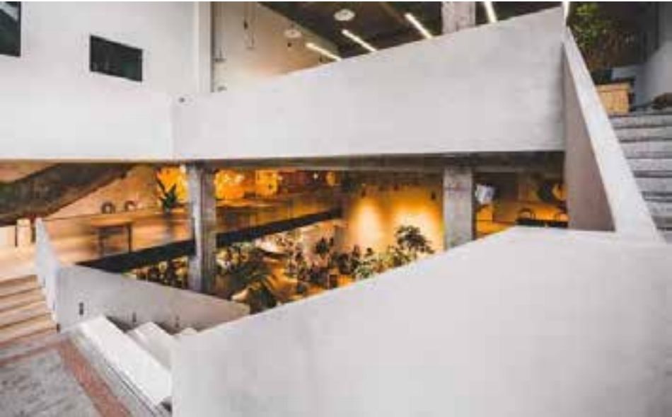
2. 防护栏杆涂有质地粗糙的灰色纳米混凝土
