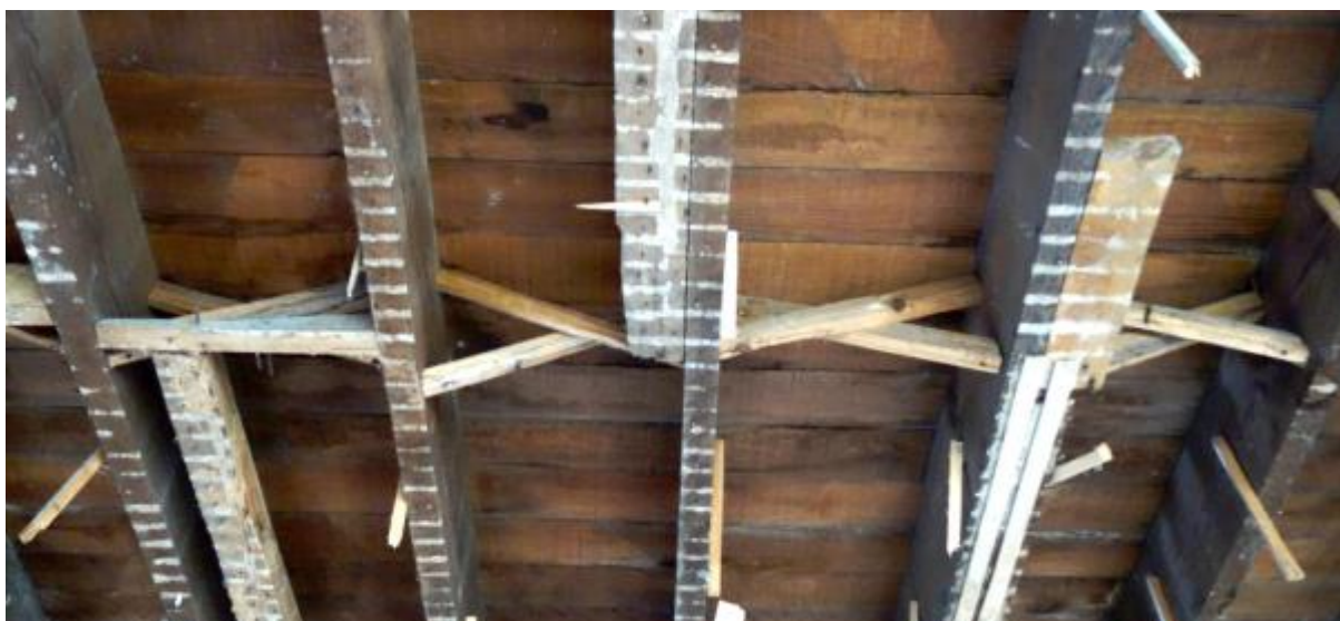
图 22 木梁之间的 X 形的木材连接件
