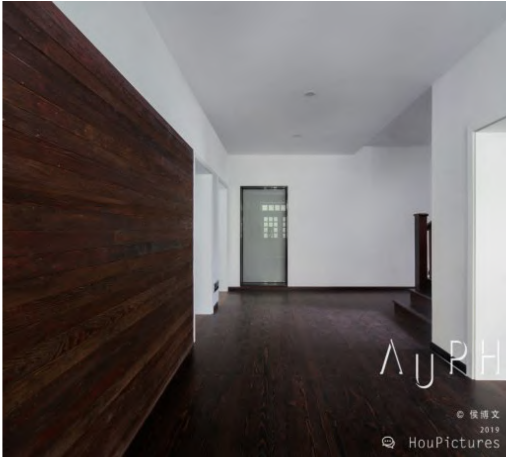
图 21 一楼拆除的木质铺板材料被铺装在一面内墙上
