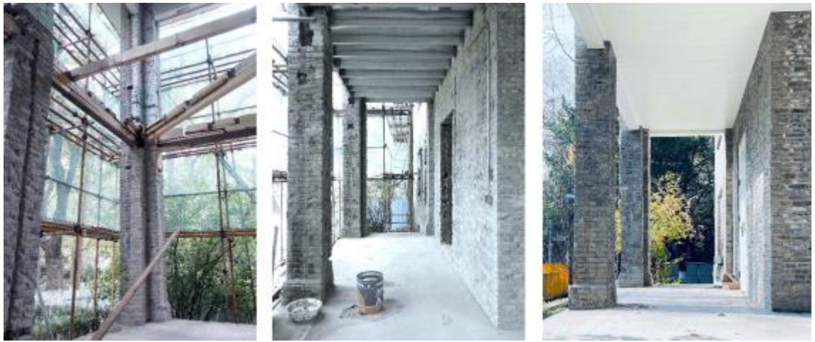
图 19 阳光敞廊的修缮过程
