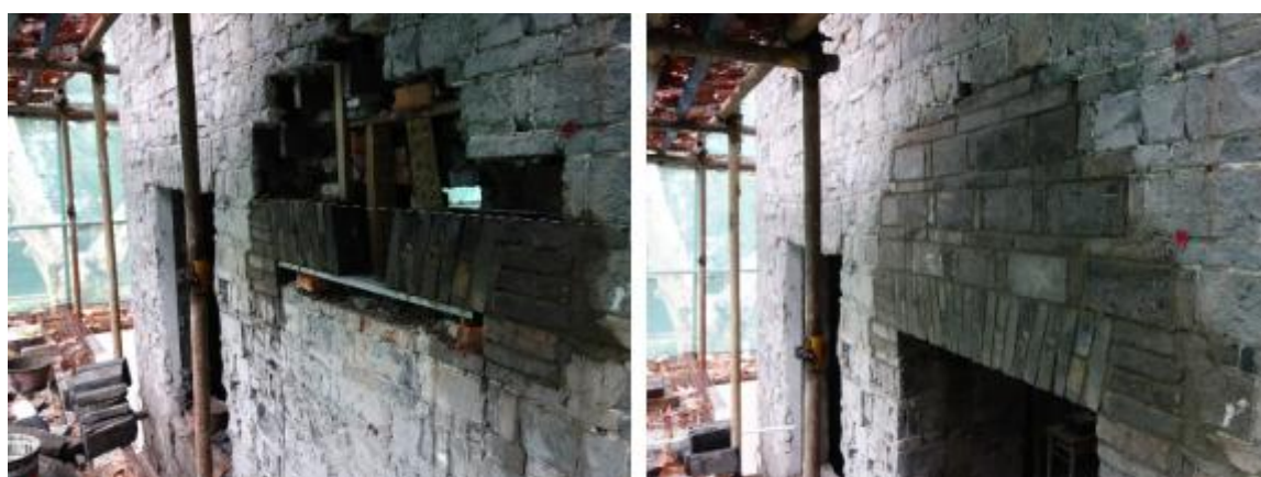
图 16 一处开洞的修缮前后
